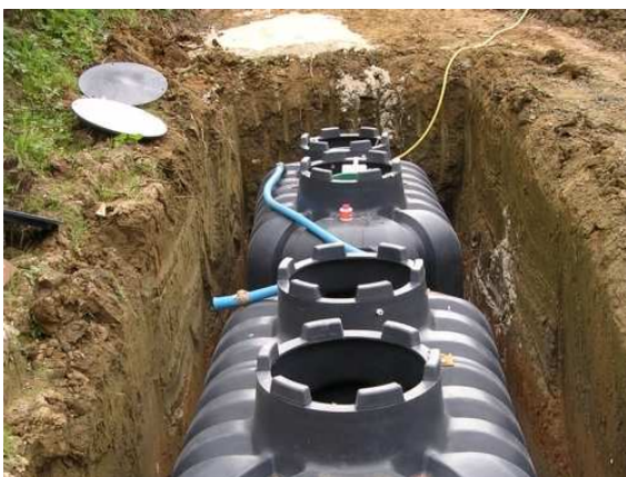
Photo d'une micro-station d'épuration enterrée (Source : hydreolia)
